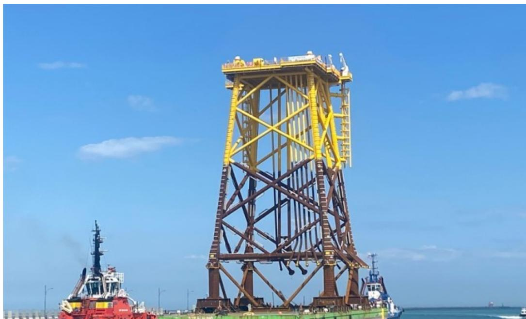
**26 Aprile 2022 - Ravenna** - Nel pomeriggio è partito dal cantiere di Marina di Ravenna della Rosetti Marino un jacket eolico T34 del peso di 1500 tonnellate e alto 60 metri, destinata al campo eolico di Fecamps, in Francia. Si tratta del secondo jacket di una serie di tre ordinati alla Rosetti dal cliente francese Chantiers de l'Atlantique.
