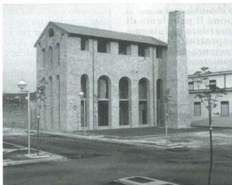
L'area ristrutturata dell'ex Almagià. Foto Biserni
