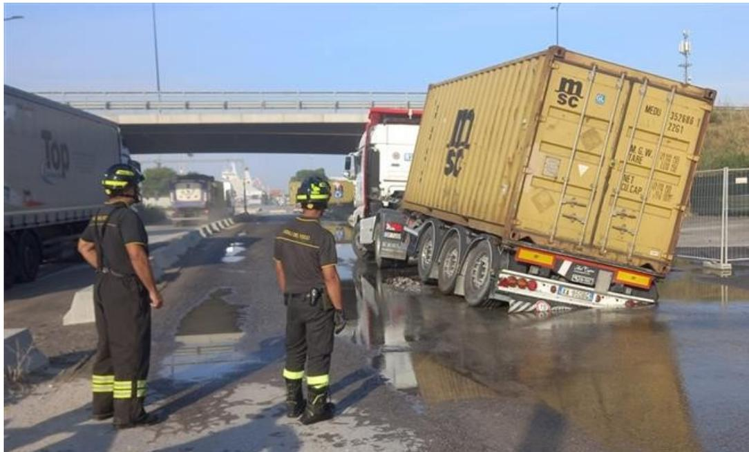
**24 Luglio 2024 - Ravenna** - La rottura di una condotta d'acqua ha provocato il cedimento del manto stradale sotto il peso di un camion che trasportava un container.
